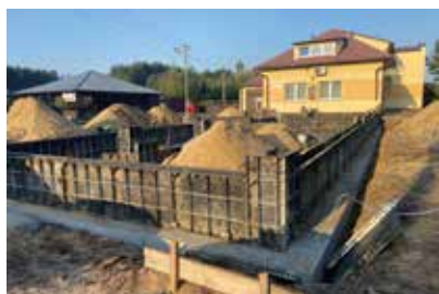
Remont świetlicy w Spiach
