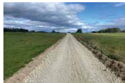
Modernizacja dróg dojazdowych do gruntów rolnych
