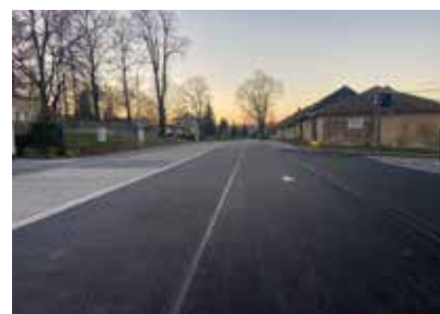
Przebudowa drogi gminnej – Dzikowiec ul.Dworska
