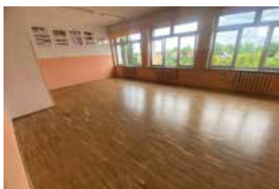
Cyklinowanie podłóg i malowanie ścian w Szkole Podstawowej w Lipnicy
