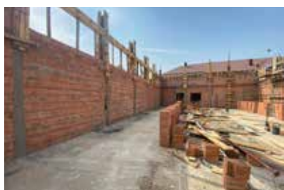
Budowa hali sportowej w Spiach
