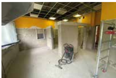
Remont pomieszczeń w Szkole Podstawowej w Dzikowcu
