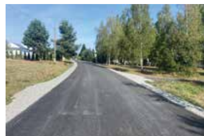
Remont drogi gminnej Wilcza Wola – Zmysłów w Wilczej Woli
