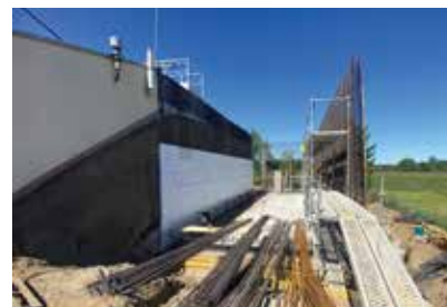
Modernizacja Oczyszczalni Ścieków w Nowym Dzikowcu
