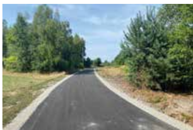
Droga w Mechowcu obok hydroforni
