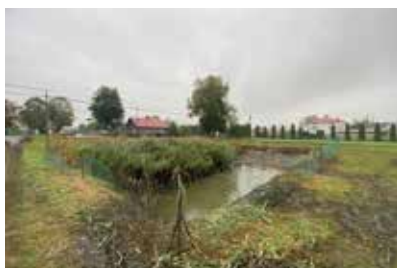
Odmulanie zbiornika p.poż. w Lipnicy wraz z wykonaniem ogrodzenia
