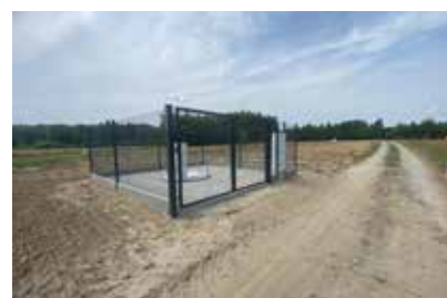
Budowa kanalizacji sanitarnej, Wilcza Wola – Pniaki
