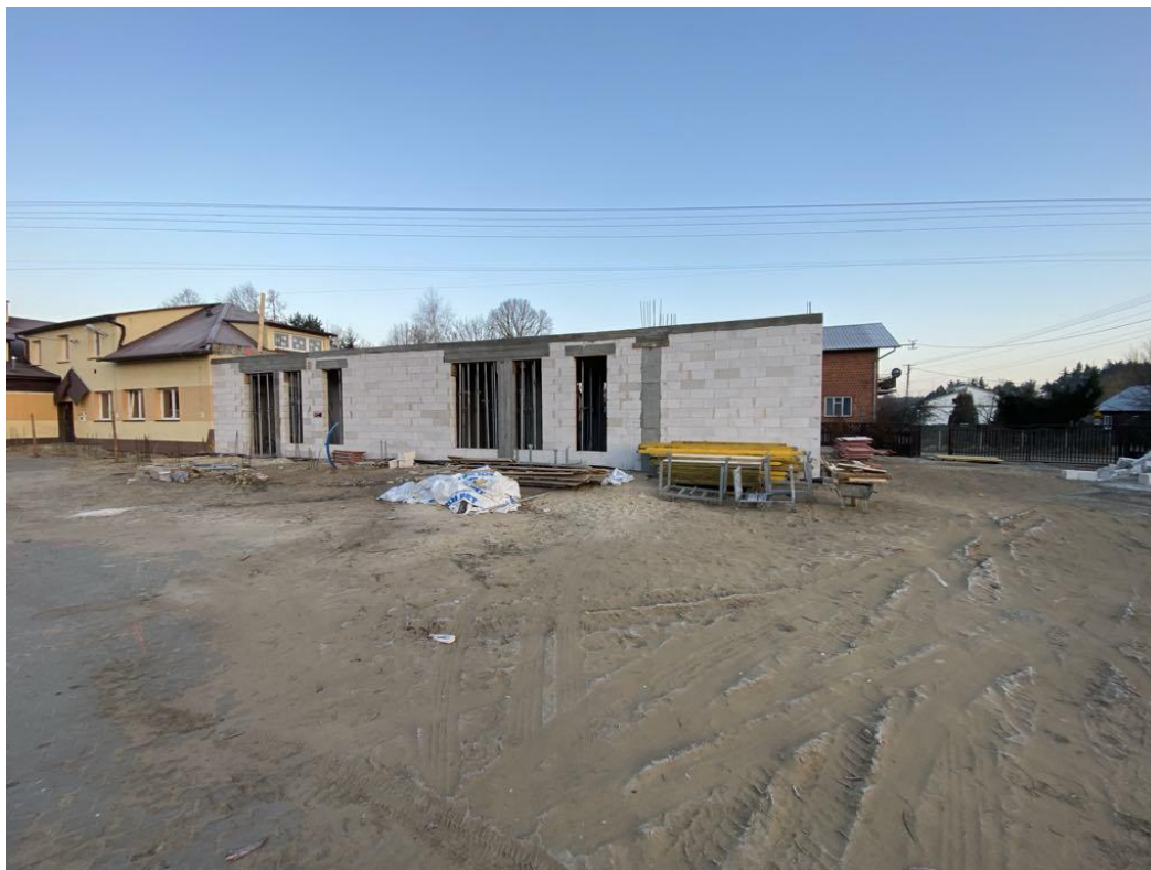
Rysunek 16 Fot. zadanie pn.: „Rozbudowa budynku wielofunkcyjnego w miejscowości Wilcza Wola – Spie” w czasie realizacji
