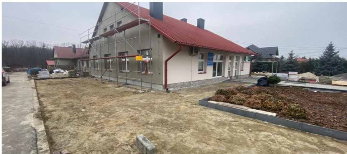
Rysunek 17 zadanie pn.: „Rozbudowa i modernizacja infrastruktury społecznej na terenie Gminy Dzikowiec” w czasie realizacji
