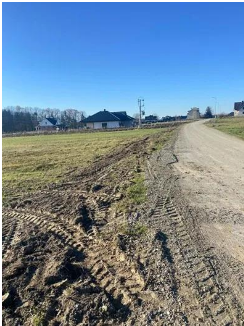
Wykonana sieć wodociągowa w miejscowości Nowy Dzikowiec
